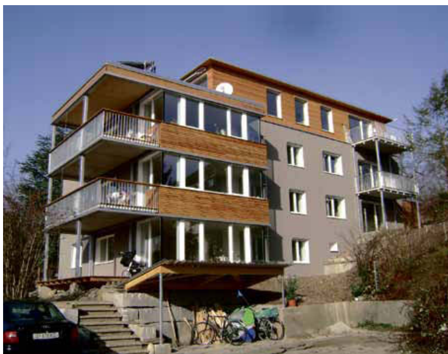
Fig. 39: Rénovation d'un immeuble d'habitation situé dans la Segantinistrasse à Höngg
