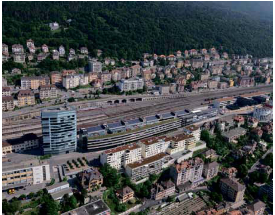
Fig. 18: Bâtiment administratif de l'Office fédéral de la statistique, Neuchâtel
