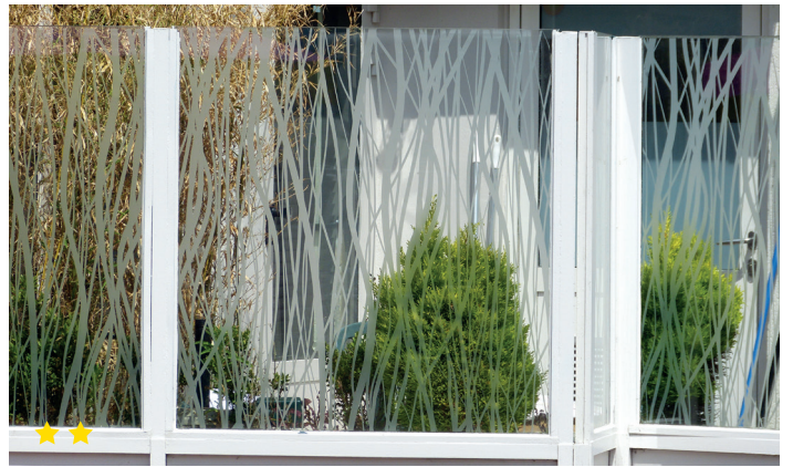
Illustration 15: Un design végétal permet d'éviter les collisions d'oiseaux avec cette paroi coupe-vent. © Archives de la Station ornithologique suisse
