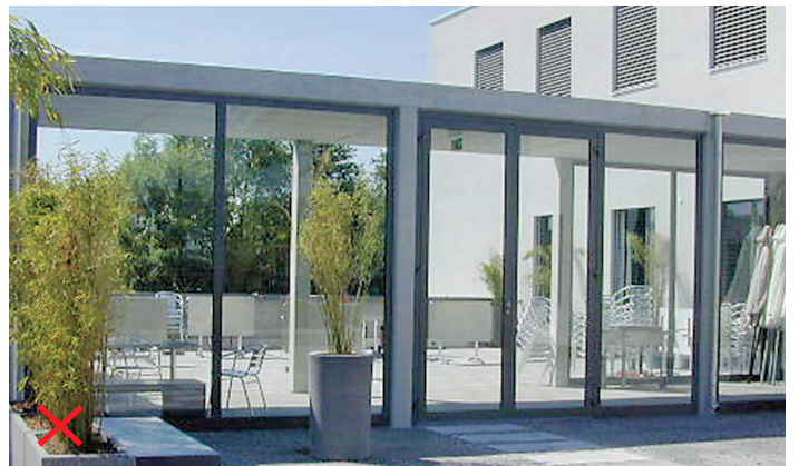
Illustration 16: Les passerelles préaux et couloirs de communication transparents font régulièrement des victimes parmi les oiseaux. © Archives de la Station ornithologique suisse
