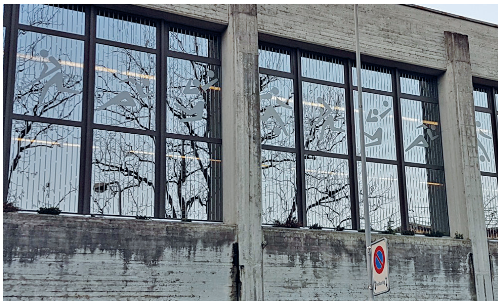
Illustration 6: Les salles de sport représentent souvent un danger en raison des reflets intenses sur de grandes surfaces. On voit ici un très bon exemple d'aménagement a posteriori. © Dominik Ruede
