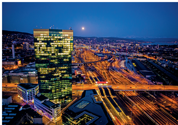
Illustration 19: La nuit, les fortes sources de lumière, par exemple sur les bâtiments de grande hauteur ou situés au niveau des cols ou au sommet de montagnes, représentent un danger pour les oiseaux migrateurs. Un éclairage bien dosé et ciblé permet de réduire la dangereuse diffusion de la lumière. © AeroPicture GmbH
