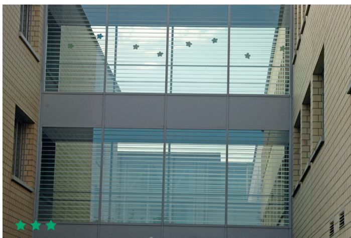
Illustrations 13 (en haut) et 14 (en bas): Des lignes nettes à fort contraste réduisent le risque de collision pour les oiseaux tout en offrant une transparence élevée pour les passerelles pour piétons, par exemple. © Médiation viennoise de l'environnement, Wilfried Doppler; archives de la Station ornithologique suisse (14)
